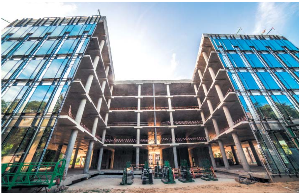
На фото: будівельний майданчик інноваційного парку LvivTech.City, Львів
